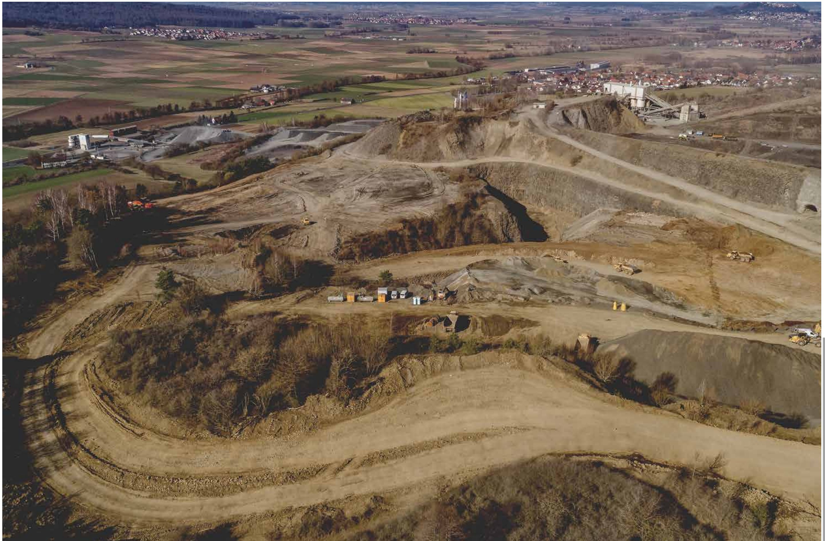
Abraumarbeiten in Nieder-Ofleiden für die MHI
